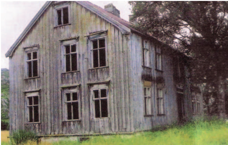
RESTAURERES. Schønninghuset" på Hjartøya skal restaureres så vil dette også bli et minnesmerke over samfunnsbyggeren Edvard Schønning's liv og virke.
